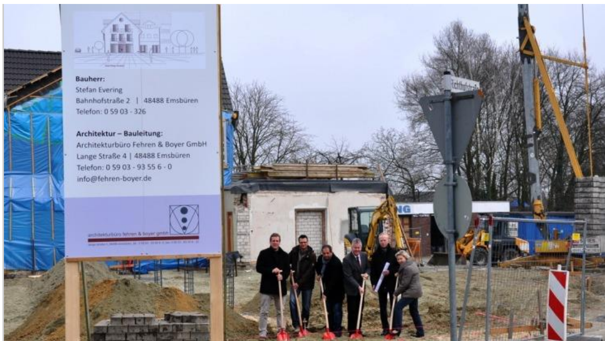
Ein neues Wohn- und Geschäftshaus baut Stefan Evering am Kreisverkehr Bahnhofstraße/Richthofstraße in Emsbüren. Foto: Felix Reis
