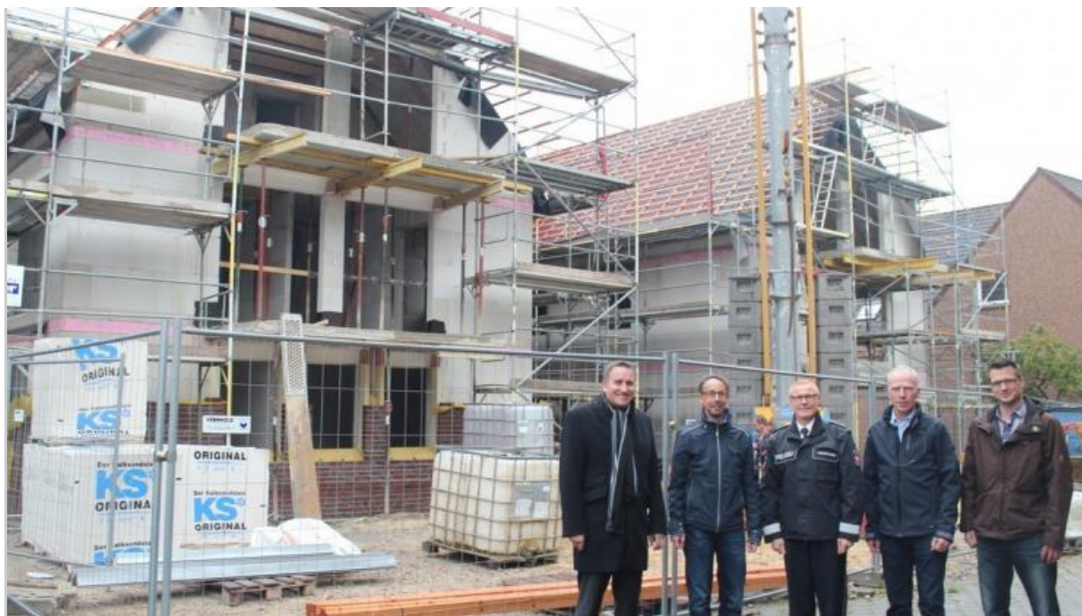
Voraussichtlich im Juni 2015 wird die Polizeidienststelle Salzbergen in diesen Neubau in Bahnhofsnähe einziehen. Zufrieden mit dem Fortschritt der Arbeiten zeigten sich Vertreter der Polizei, der Gemeinde sowie der Investoren. Foto: BremenKamp
