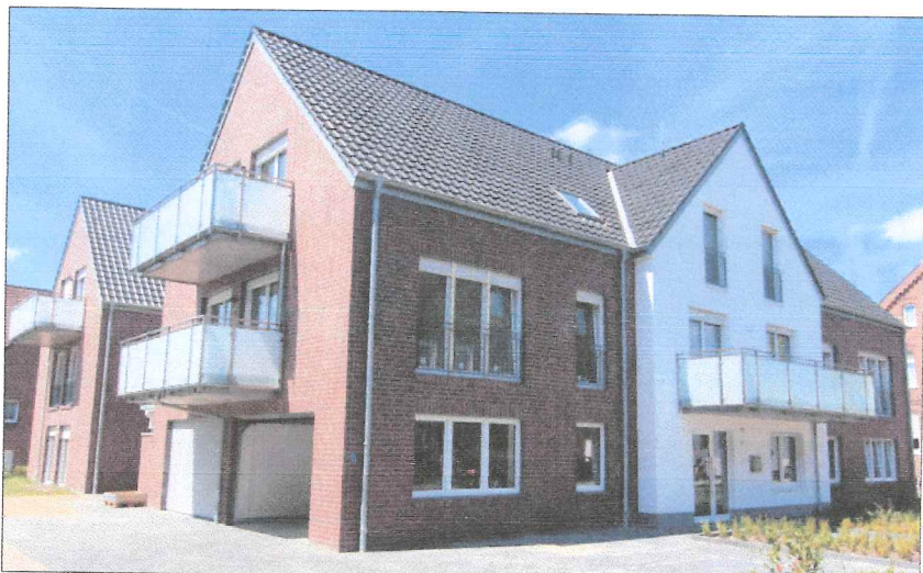
Im Erdgeschoss dieses für rund zwei Millionen Euro errichteten Wohn- und Geschäftshauses in unmittelbarer Nähe des Salzbergener Bahnhofs ist die neue Polizeidienststelle zentraler Anlaufpunkt für etwa 7800 Bürgerinnen und Bürger.
