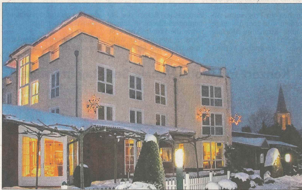
Der Landgasthof Evering trägt mit der neuen baulichen Situation dazu bei, dass sich das Bild von Emsbüren sehr positiv verändert hat.
